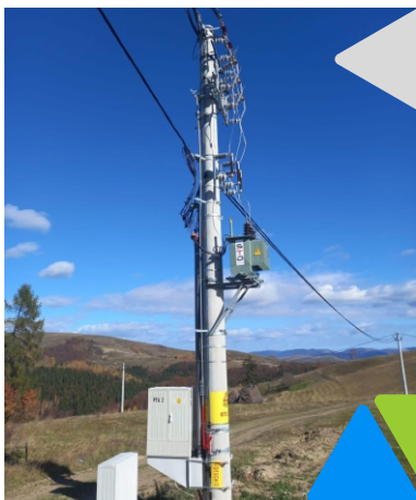
Modernizare LEA 0,4 kV și brașamente Cristești
