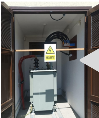
Modernizare LEA JT Crăciunelu de Jos
